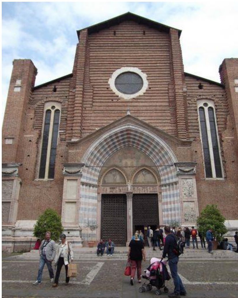
Facciata della basilica di Santa Anastasia
